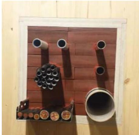
**Abbildung 17: Abschottung mit Hilti CFS-BL P innerhalb einer klassifizierten Öffnungsleibung [51]**
