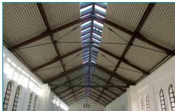
Insbesondere vorgefertigte Zugstabsysteme kommen dabei zum Einsatz. Durch die Anwendung von reaktiven Brandschutzbeschichtungen können solche Bauteile gegen Brand-
