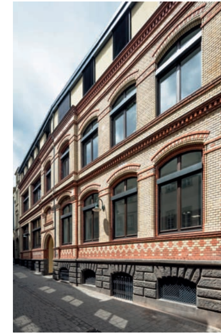
Moderne Fassadenelemente ergänzen die historische Klinkerfassade an der Wagemannstraße
