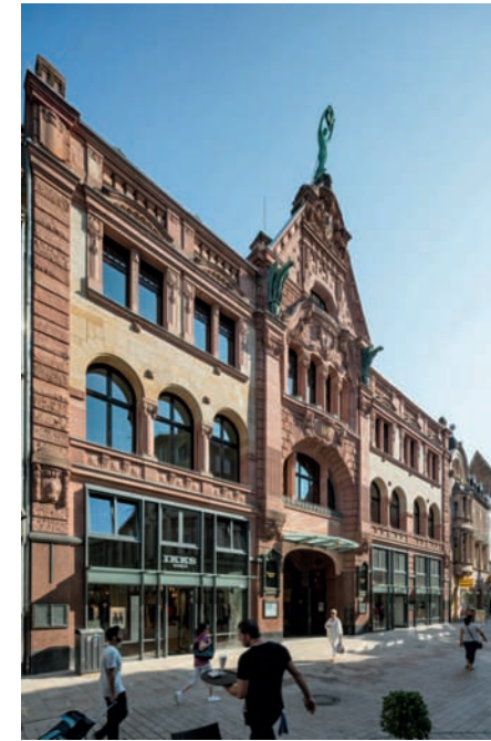
Im Gebäudeteil zur Langgasse hatte der Erhalt des identitätsstiftenden Bestands Priorität
