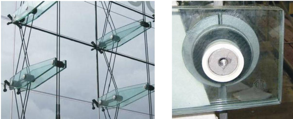
**Bild 1.2: Eingangsfassade Hauptbahnhof Berlin, Scher-Lochleibungsverbindungen der Glasschwerter, die zur Aussteifung der Fassade herangezogen werden**
