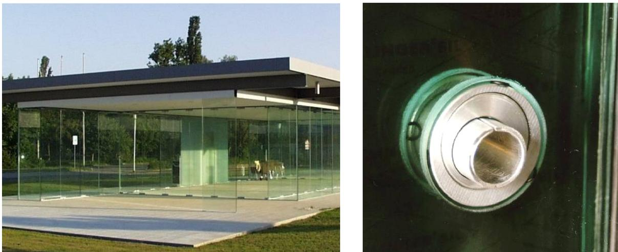
**Bild 1.3: Pavillon der Sommerakademie in Rheinbach, Anschlussdetail SL-Verbindungen**
