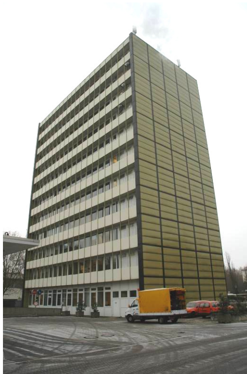
Bild 1: Ansicht des bestehenden Hochhauses
