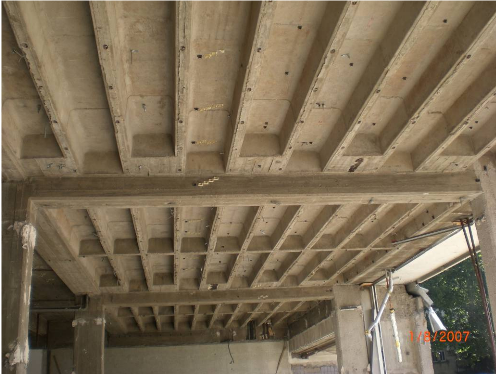
Bild 3: Rippendecke im Gebäudebestand
