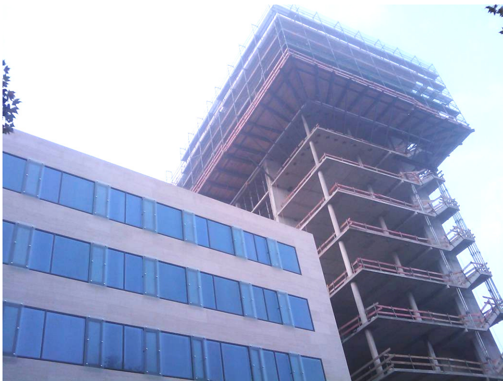
Bild 4: Bauphase Aufstockung des Hochhauses
